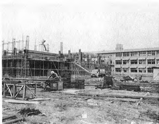
▲県立小川工業高校 昭和49年4月開校、50年度完成を めざし、急ピッチで建設中です
