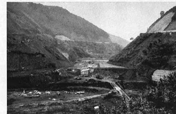
▲清願寺ダム（球磨郡上村） 洪水調節を行い用水を確保して農家の経営 安定向上を図るもの 50年度完成予定
