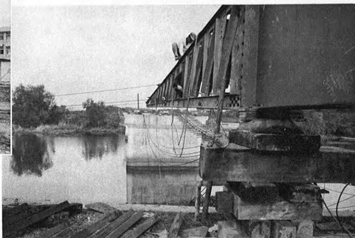
▲八代・松橋地区広域営農団地農道整備事業（大鞘川橋 梁工事）農道網の整備により農業の大型化・近代化に よって、広域営農団地の形式を目指すもの 昭和55年3月完成予定
