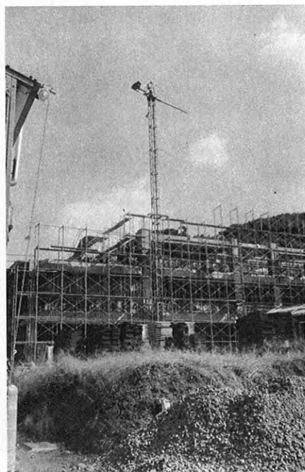
▲勤労者福祉センター 昭和50年7月完成予定 宿泊施設完備
