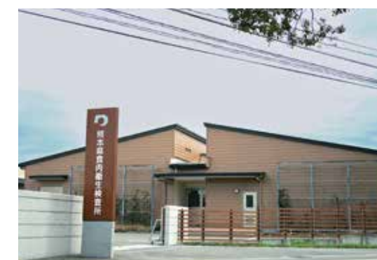
熊本県食肉衛生検査所 (R2.11 完成)
