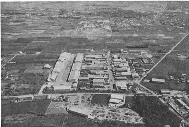
▲熊本I・C.近くに立地して有利になった鉄工団地
