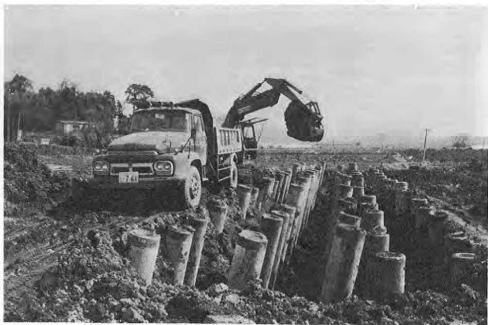
建設進む九州自動車道（御船工区）
