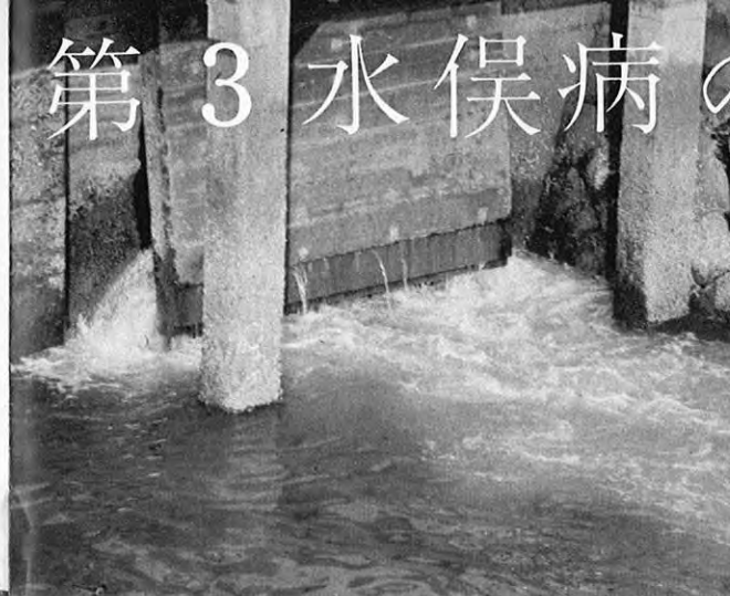
▲チソン水俣工場の排水口
