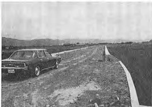
▲ 道床が出来上がった大規模農道（八代市）
