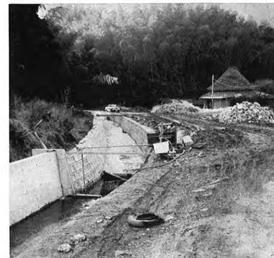
▲排水路の整備も着々と進む
