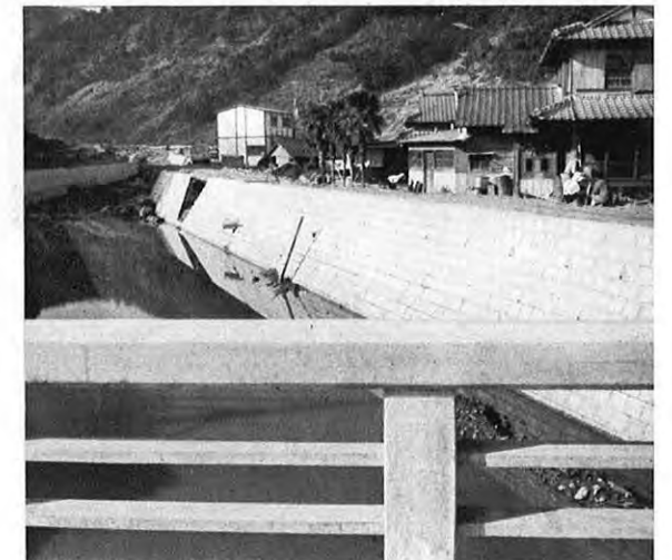
▲下貫川の護岸堤防も復旧
