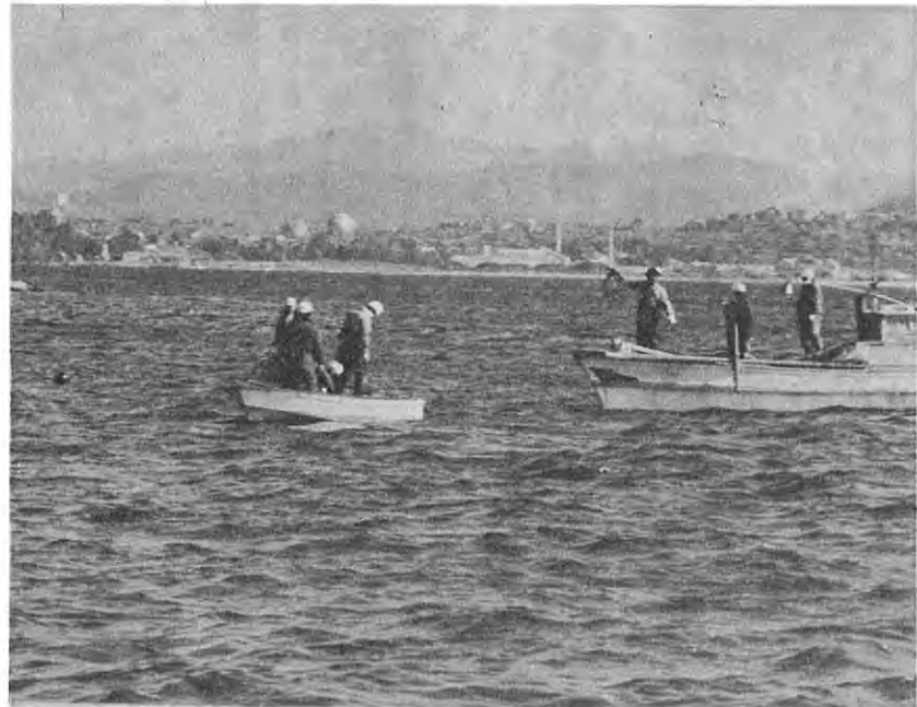
水俣湾の網締切のためのふい敷作業
