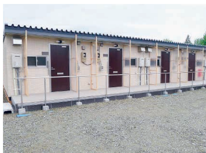
コンテナ型仮設住宅(東日本大震災)
