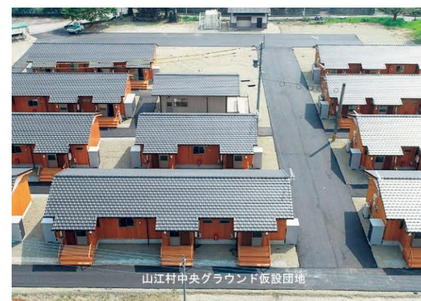
■ 山江村中央グラウンド仮設団地(令和2年7月豪雨)
