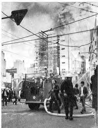
▲全力を上げての消火活動もむなし
