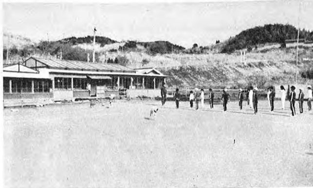
▲スカイライン沿線に仮住いする内ノ牧小学校深谷分校
