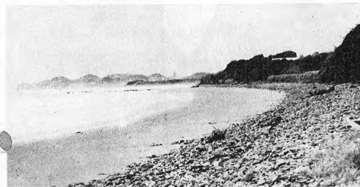
▲右側コンクリート擁壁がケーブル揚陸地点
