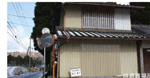
昨年7月の熊本広域大水害の際は、見守りネットワークを生かして、隣保班単位で設置してある一時避難場所への避難誘導などを行いました。
