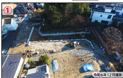
区画道路、宅地造成工事の状況
