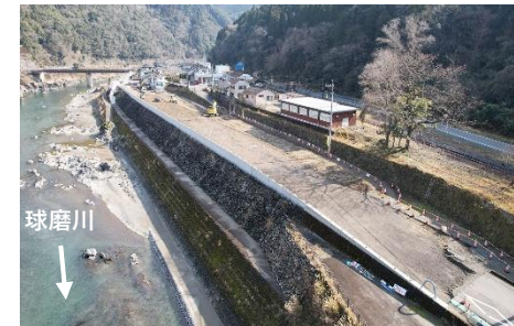
友尻地区工事進捗状況1月末時点 【球磨村友尻地区】
