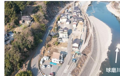
白石地区工事進捗状況1月末時点 【芦北町白石地区】
