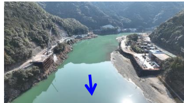
③鎌瀬橋(国道219号)
