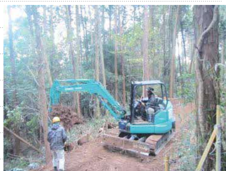
【作業道作設状況】
