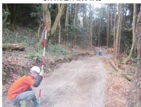
【敷砂利敷設状況】
