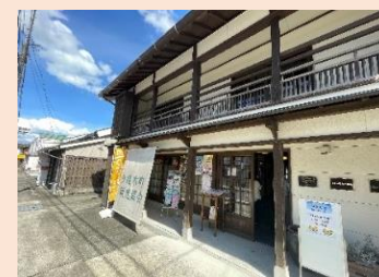
空き家をこどもの学習スペースとしても利用 活用法交流施設に改修した例(多良木町)
