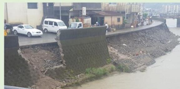
令和2年7月豪雨時の堤防護岸の崩壊状況
