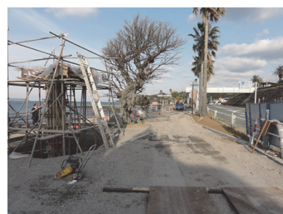
工事状況(平成25年2月8日現在)
