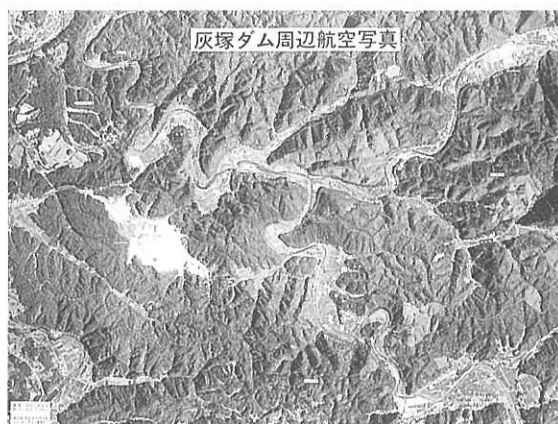
ダムエリアの空撮
