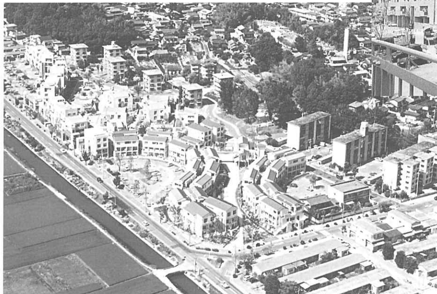
岡山県営中庄団地建替第1期および第2期（空撮）
