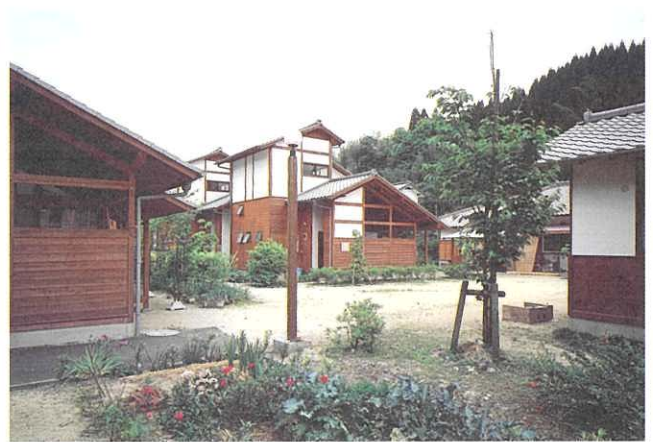
●東陽村宮淵の本団地
