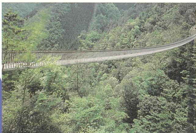
●梅の木轟公園吊橋
