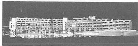
熊本市営新地団地C 設計＝富永譲
