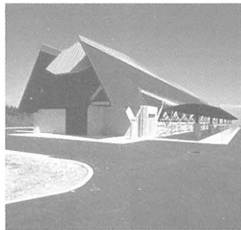
草地畜産研究所畜舎 設計=トム・ヘネガン& インガ・ダグフィンスドッター、桜樹会・古川 建築事務所 ©石丸捷一
