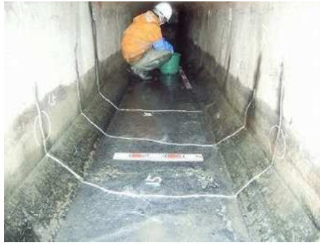
写真 2.1-13 樋管のクラック発生状況
