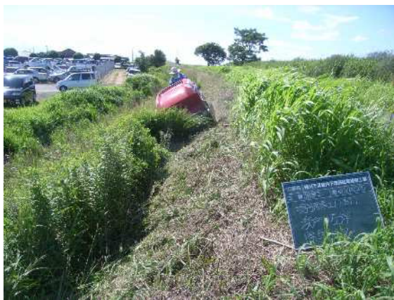
写真 4.3-3 堤防除草作業
