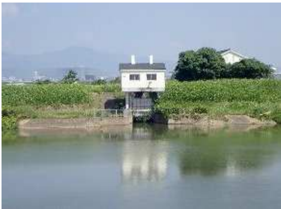
写真 4.2-9 画図第二排水樋管
