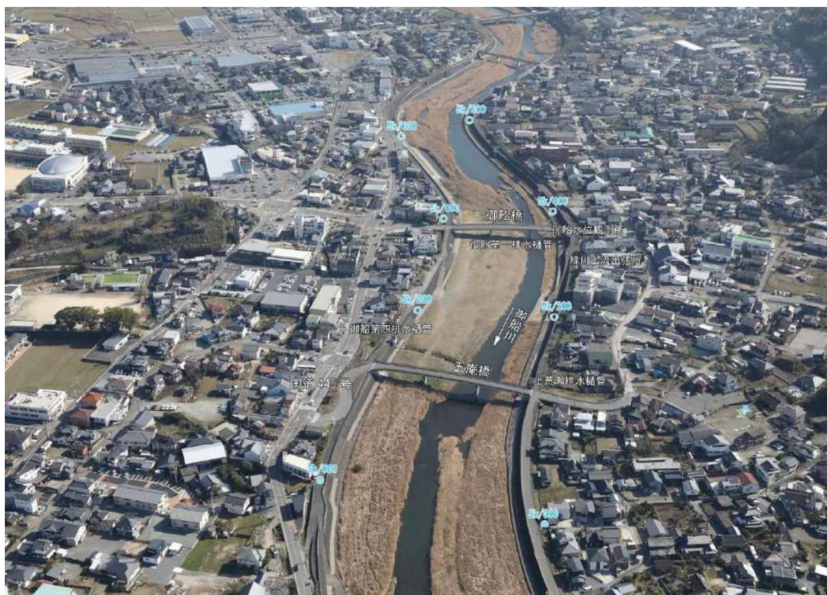
写真 4.2-6 五庵橋付近（御船川 5k2 付近）
