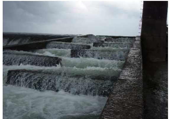
写真 4.2-8 築地堰の魚道
