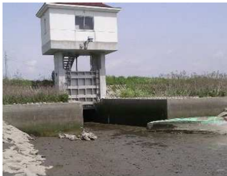
写真 2.1-14 樋管前面のガタ土堆積状況
