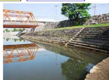
工事完了後の船着き場
