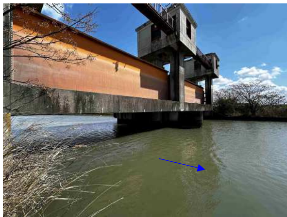
写真 2.3-34 浜戸川との合流部潤川水門
