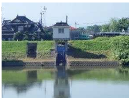
写真 2.3-64 犬渚1号排水樋管(加勢川 5k800)
