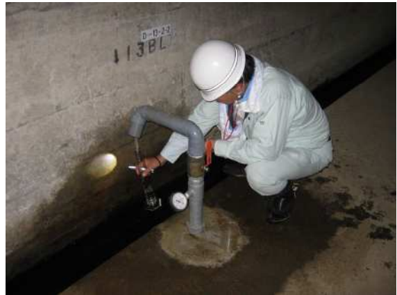
写真 4.3-2 ダムの施設点検状況
