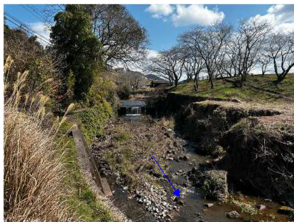
写真 2.3-35 花園池と潤川の接続区間
