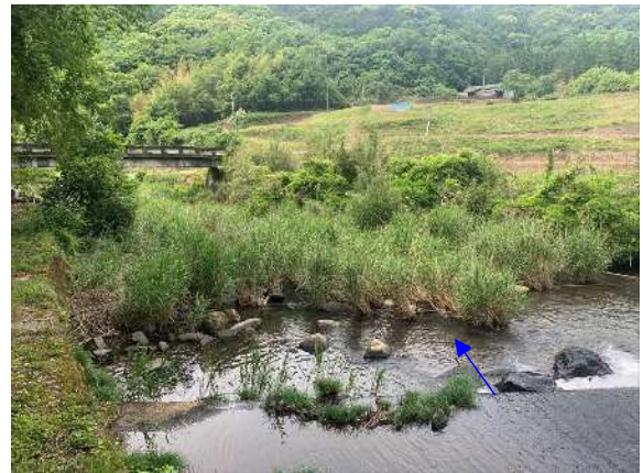
写真 2.3-42 上流部の区間
