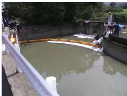
写真 4.3-33 水質事故時の対策 水質事故発生時には、適切な箇所で オイルフェンスや吸着マットなどを 設置し、下流への被害の拡大を防止し ます。
