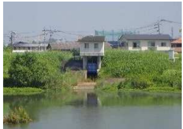
写真 4.2-10 瀬ノ江排水樋管
