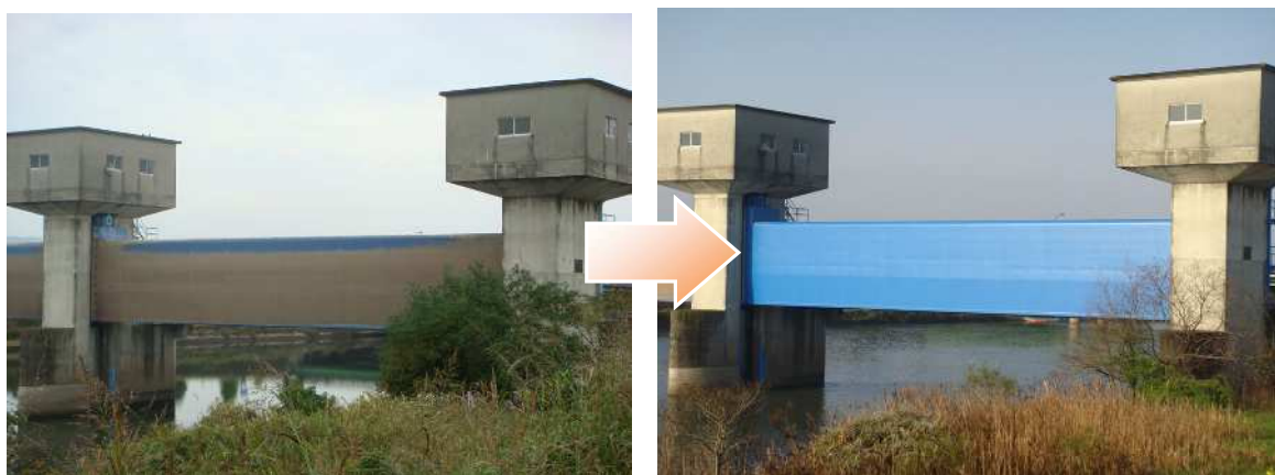
写真 4.3-5 ゲート塗装前・後（防錆対策）
