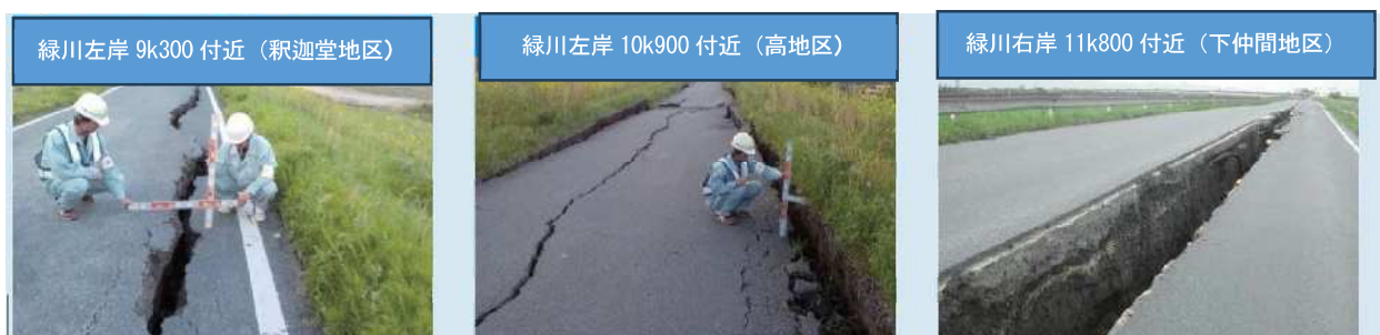
写真 2.1-7 緑川における緊急点検状況
