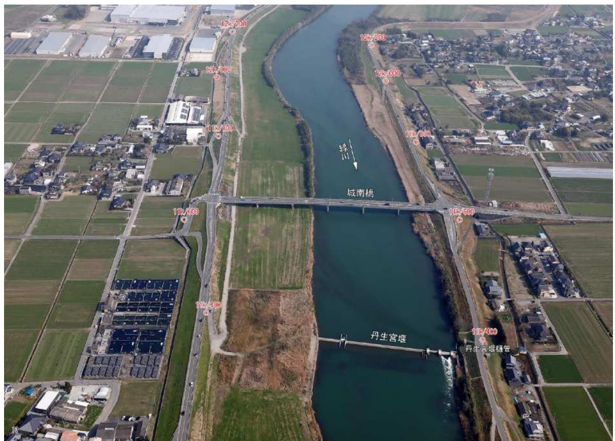
写真 4.2-2 城南橋付近（緑川 11k6 付近）
