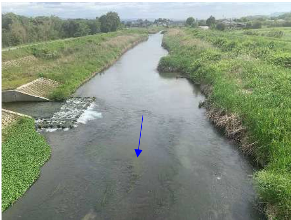
写真 2.3-41 浮島池からの流入部
