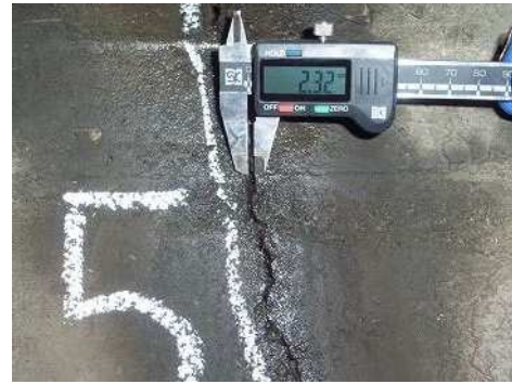
写真 2.1-13 樋管のクラック発生状況
