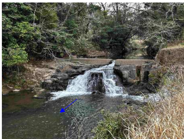
写真 2.3-59 五老滝川の石積み堰
