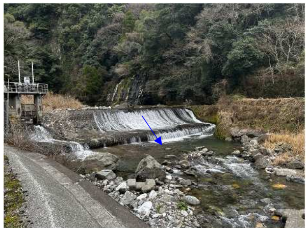
写真 2.3-56 千滝川の落差工
