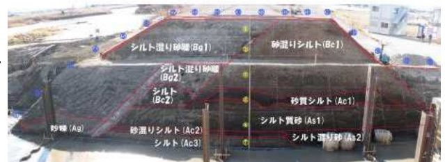
写真 2.1-1 加勢川右岸清正堤の断面状況
