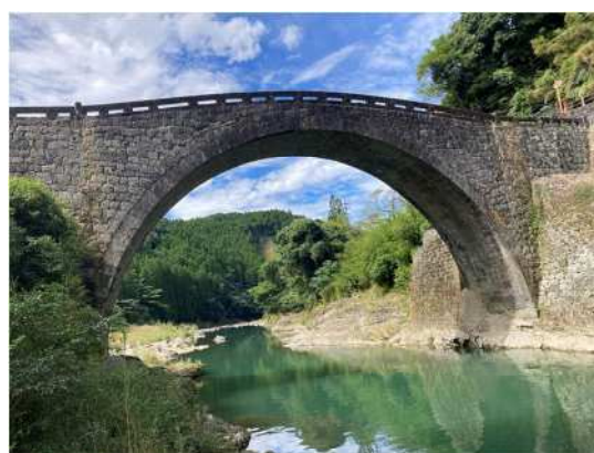
写真 1.1-26 霊台橋（美里町）
