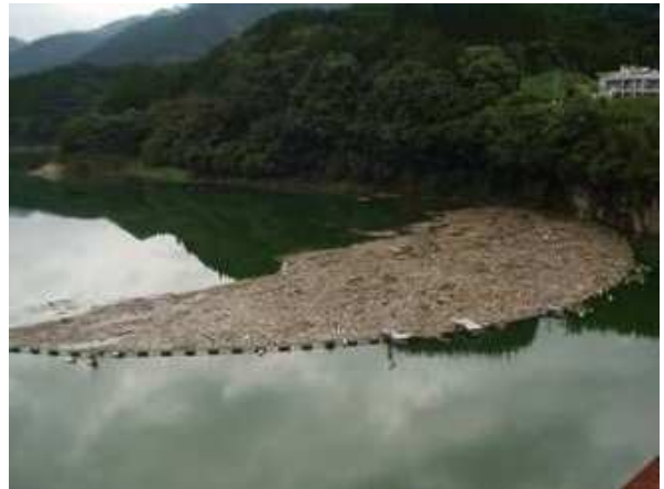
写真 4.3-7 洪水により発生した 流木等の捕捉（緑川ダム）
