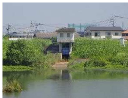
写真 2.3-65 瀬ノ江排水樋管(加勢川 9k000)
