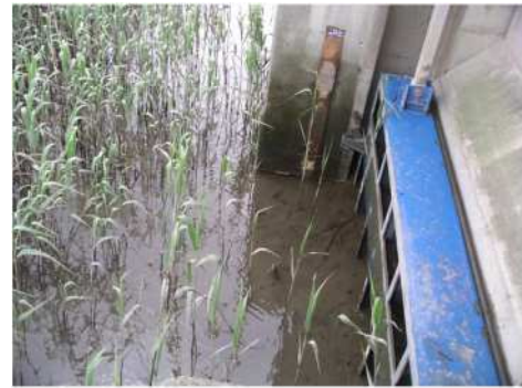
写真 2.1-14 樋管前面のガタ土堆積状況
