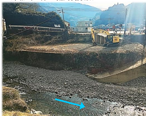
<令和6年12月17時点 現場状況>
