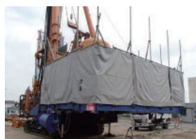
防音シートの設置の状況
