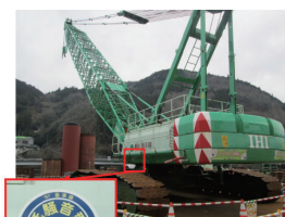
低騒音型建設機械の状況
