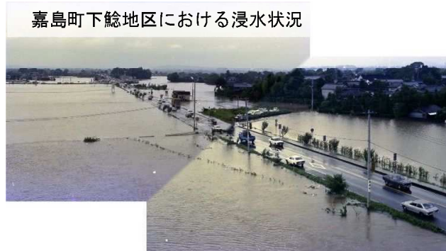
写真 1.2-11 昭和 57 年 7 月洪水時の状況
