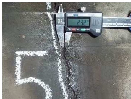
写真 2.1-13 樋管のクラック発生状況
