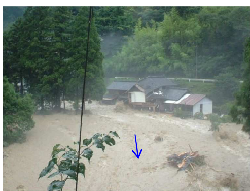
写真 1.2-14 平成 19 年 7 月 洪水時の土石流災害状況（柏川）
