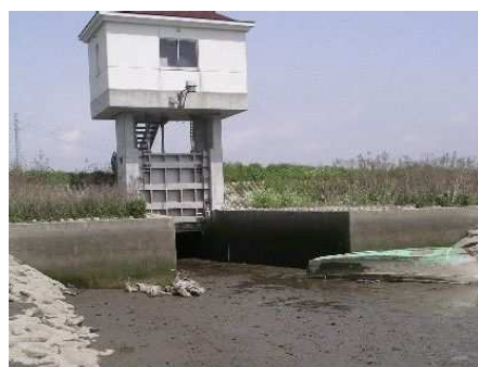
写真 2.1-14 樋管前面のガタ土堆積状況
