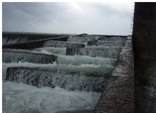
写真 4.2-8 築地堰の魚道
