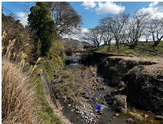
写真 2.3-35 花園池と潤川の接続区間
