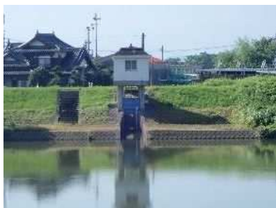
写真 2.3-64 犬渚1号排水樋管(加勢川 5k800)
