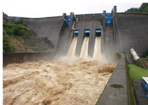
写真 4.3-9 緑川ダムからの放流状況
