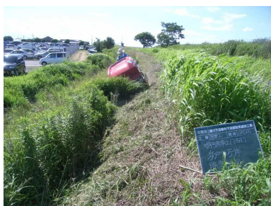
写真 4.3-3 堤防除草作業
