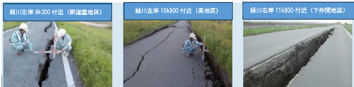
写真 2.1-7 緑川における緊急点検状況
