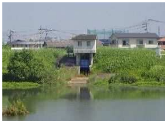
写真 4.2-10 瀬ノ江排水樋管
