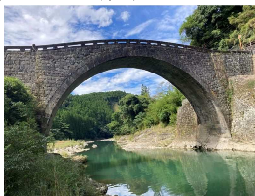
写真 1.1-26 霊台橋（美里町）
