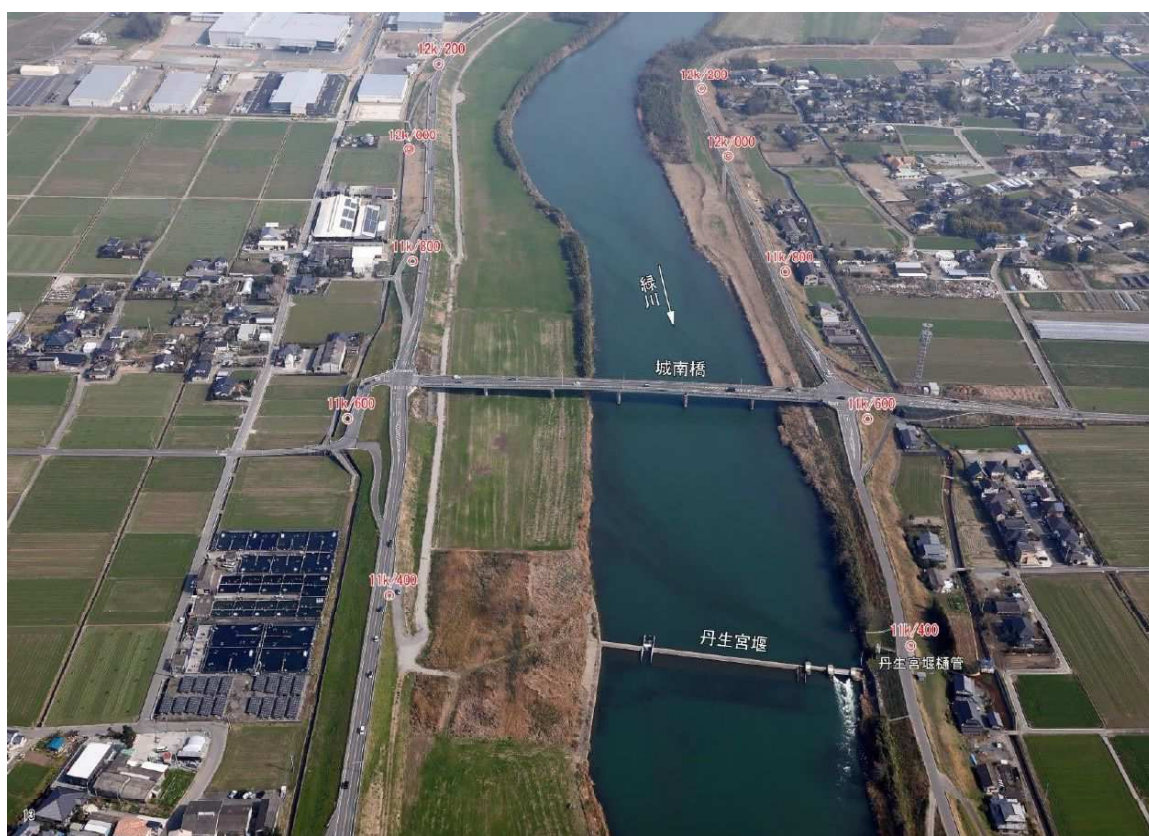
写真 4. 2-2 城南橋付近（緑川 11k6 付近）
