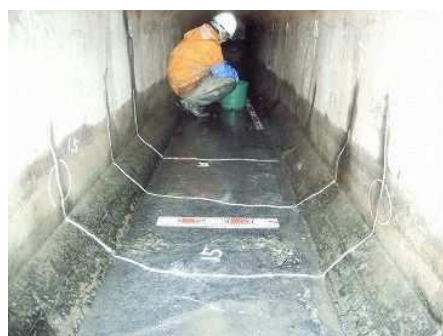
写真 2.1-13 樋管のクラック発生状況
