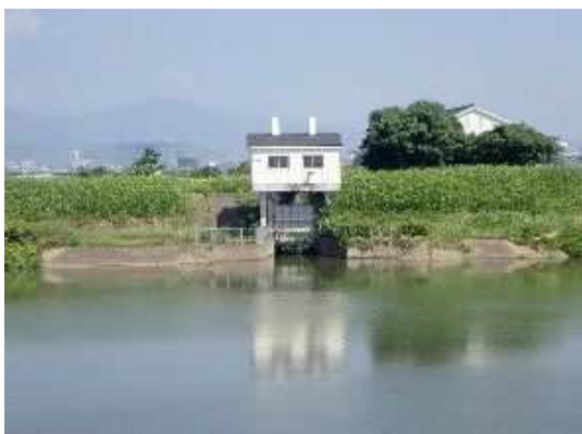
写真 4.2-9 画図第二排水樋管
