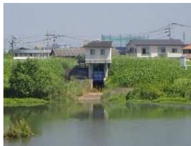
写真 2.3-65 瀬ノ江排水樋管(加勢川 9k000)
