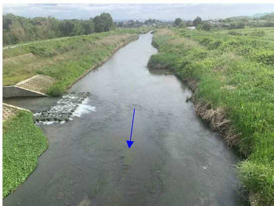
写真 2.3-41 浮島池からの流入部
