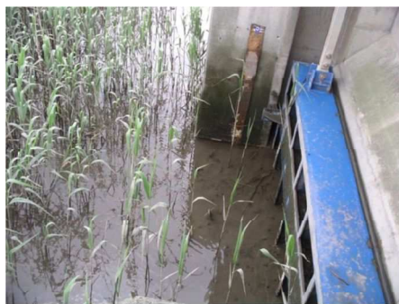
写真 2.1-14 樋管前面のガタ土堆積状況
