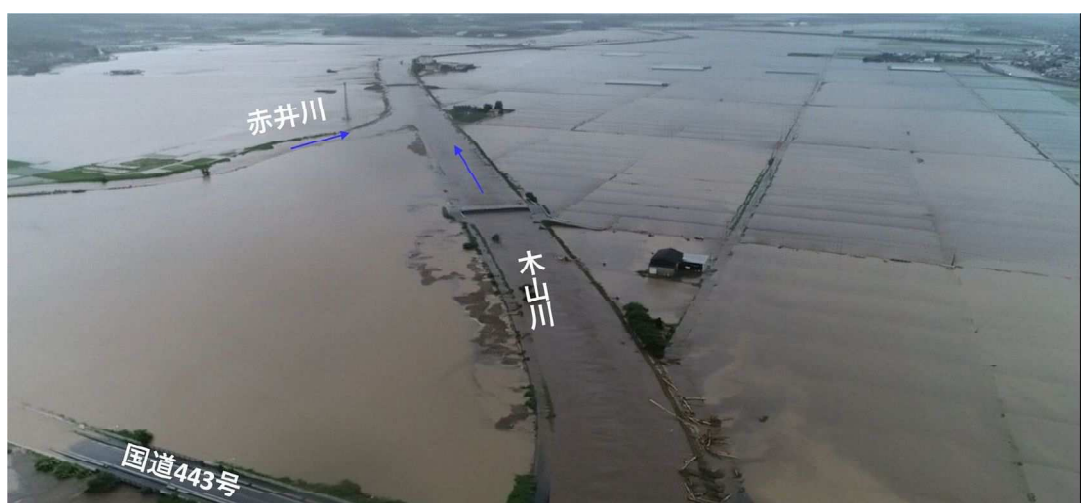
写真 1.2-17 令和5年7月洪水時の状況
