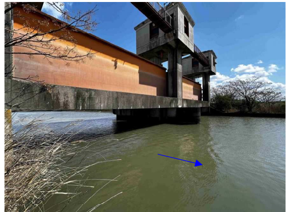
写真 2.3-34 浜戸川との合流部潤川水門
