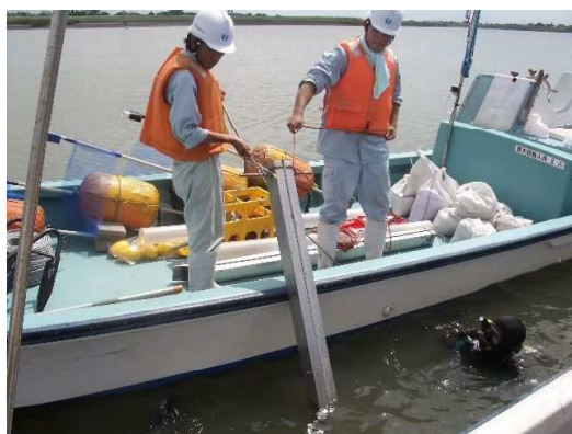
写真 4.3-27 河床堆積物調査
