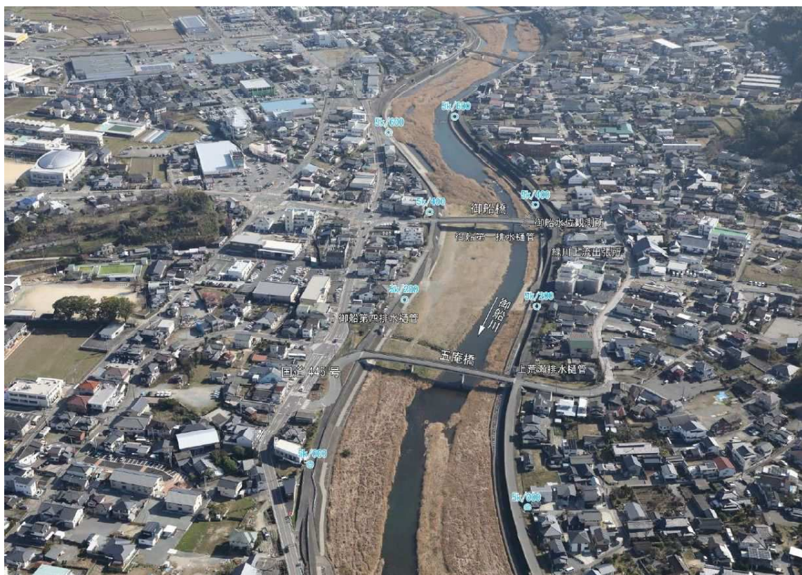
写真 4.2-6 五庵橋付近 (御船川 5k2 付近)
