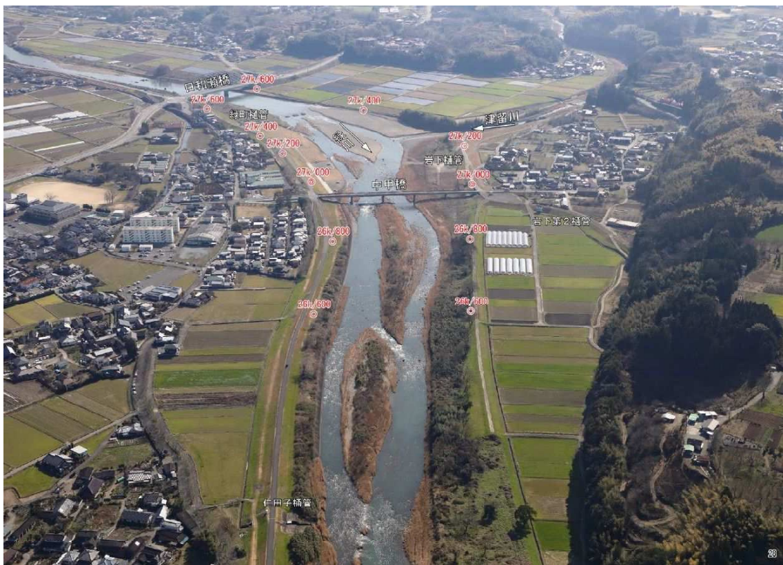
写真 4.2-1 中甲橋付近（緑川 27k0 付近）
