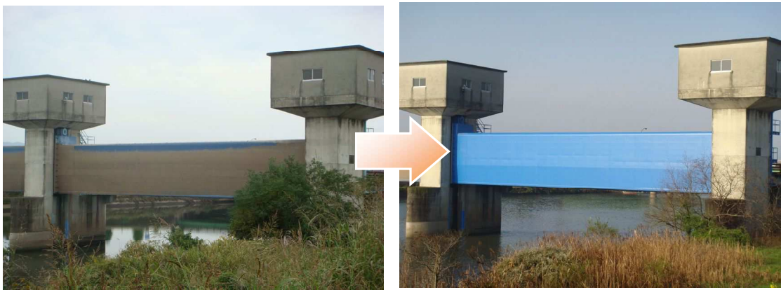
写真 4.3-5 ゲート塗装前・後（防錆対策） ゲート塗装を行い、錆による劣化を防ぎ、施設の機能を維持します。
