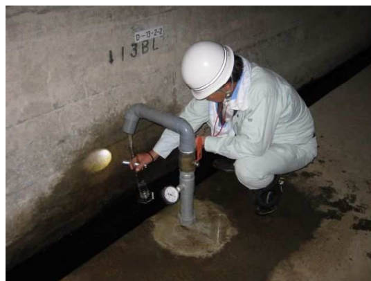
写真 4.3-2 ダムの施設点検状況
