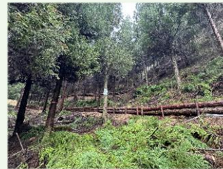
土砂流出対策の筋工(五木村)
