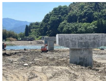
球磨川第4橋梁の工事状況(R6.5)
