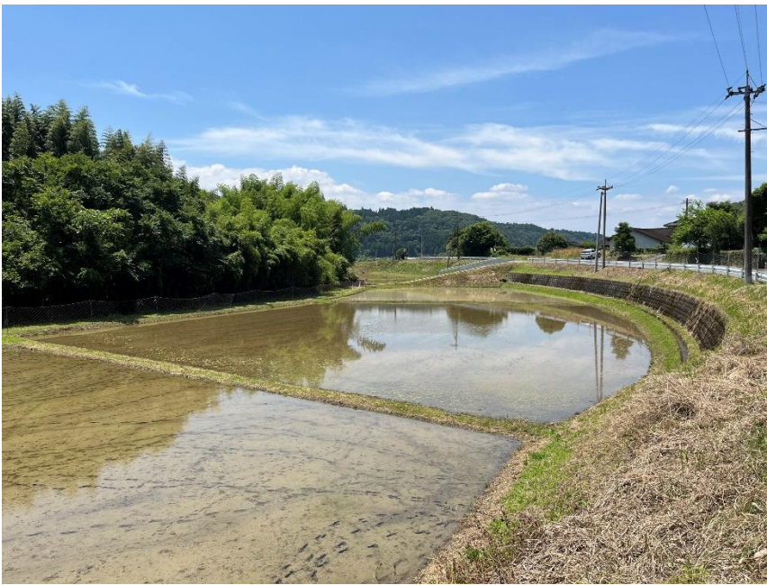
現況写真①
