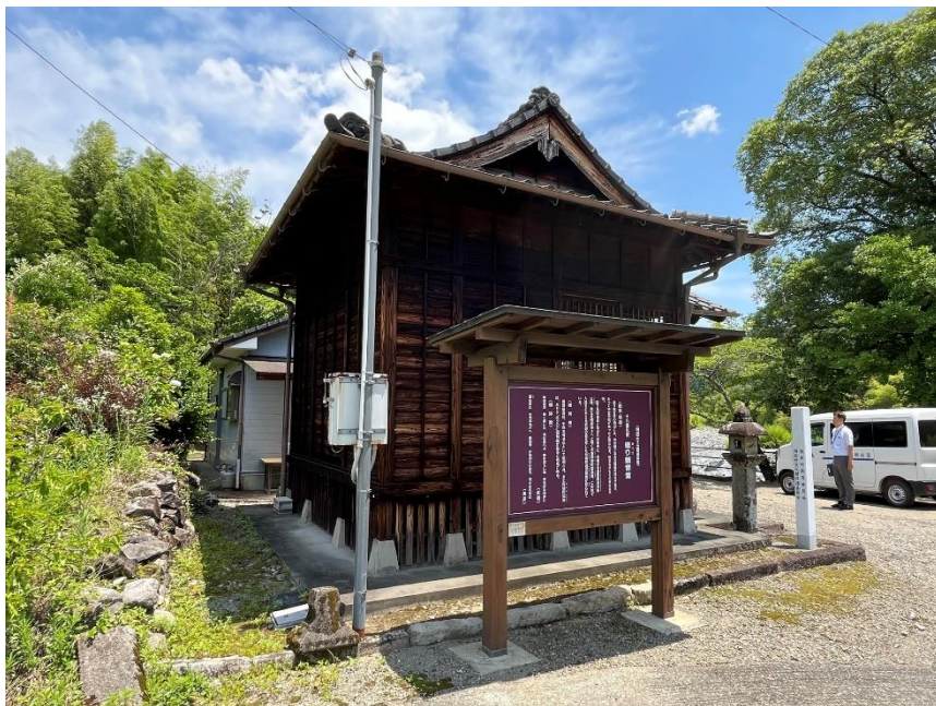
現況写真⑦
