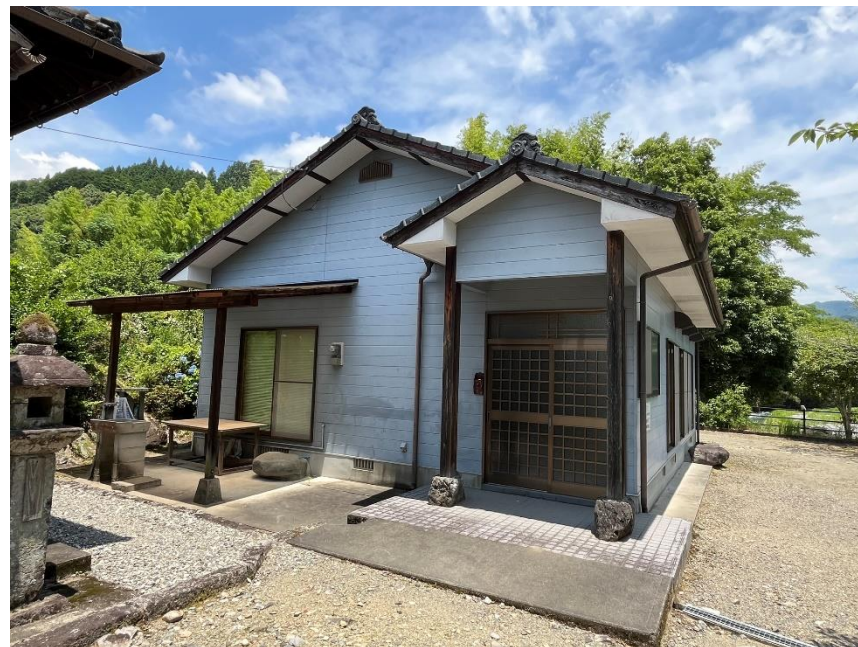
現況写真⑧ 既存の廻地区コミュニティセンター（撤去予定）
