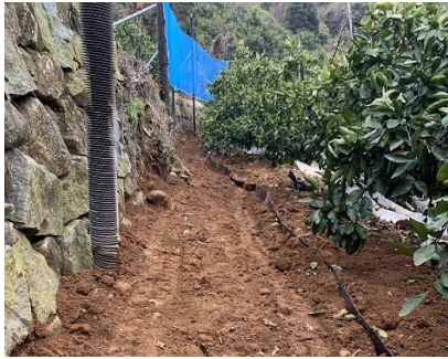
図1 NARO S.シート埋設状況 (通路側(畝の片側)のみに埋設)
