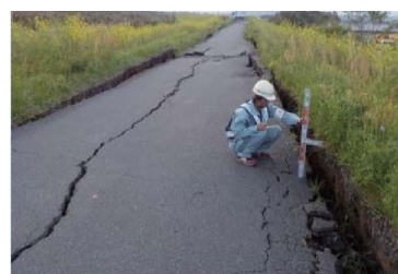
緑川における緊急点検 緑川左岸10k900付近 (高地区)
