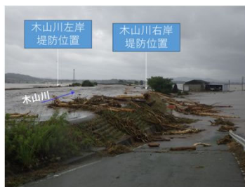
国道443号 新木山橋付近
