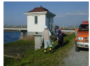
河川巡視の状況
