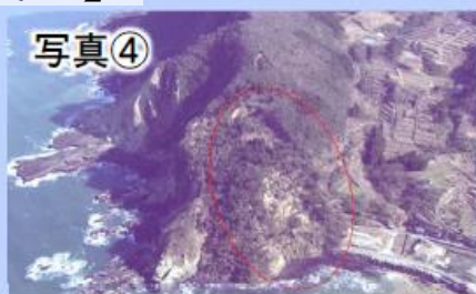
国道249号トンネル坑口崩落
