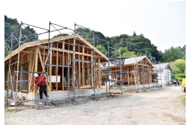
【人吉市における建設型応急住宅建設状況(当時)】
