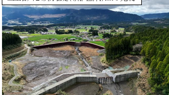
三王谷川2砂防堰堤((南阿蘇村)R6.3完成)
