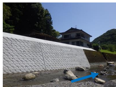
復旧状況（令和5年6月完了）
