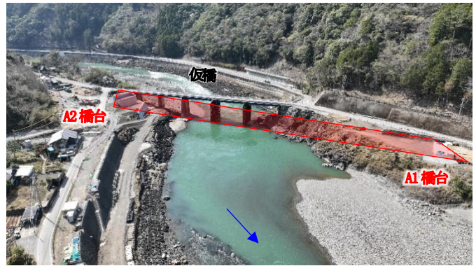
国道219号 鎌瀬橋施工状況 (令和6年4月)
