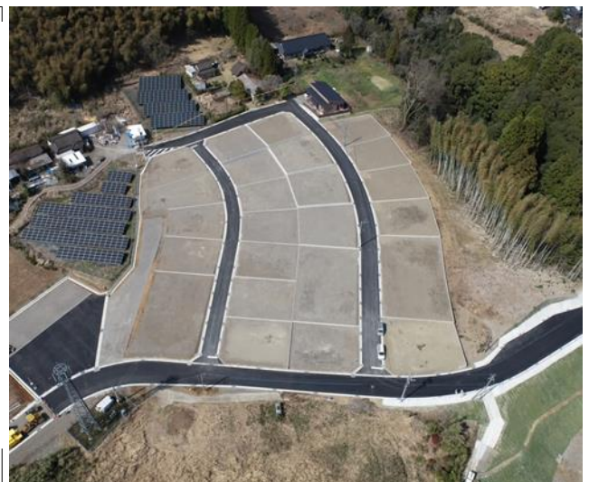
被災住宅移転促進宅地整備事業で整備された宅地(球磨村渡地区)
