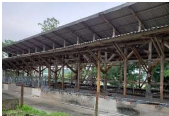
空き牛舎改修（スチール・屋根）
