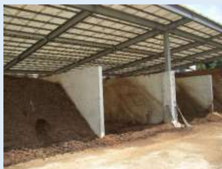
（堆肥舎の例）床と側壁はコンクリート、 上は屋根で覆われている
