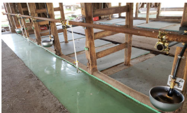
空き牛舎改修後 （ウォーターカップ、飼槽、ネックール、牛床マット）
