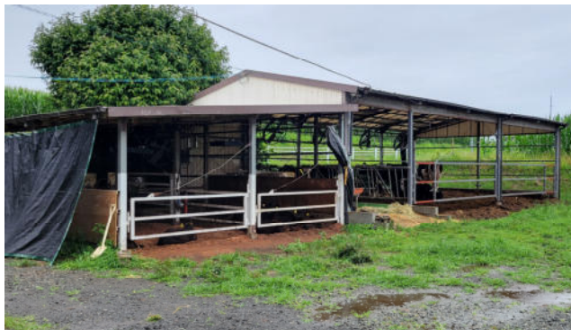
空き倉庫改修（乾乳舎）
