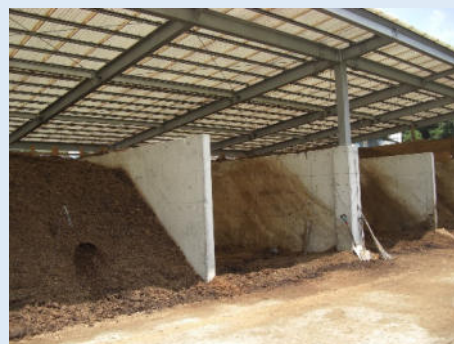
（堆肥舎の例）床と側壁はコンクリート、 上は屋根で覆われている
