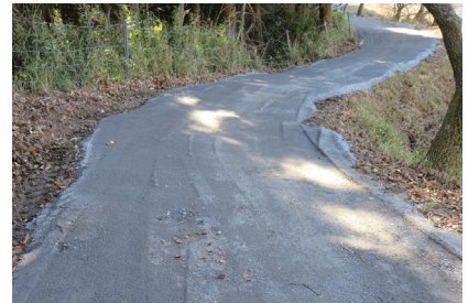
恒久輪地整備実証事業
