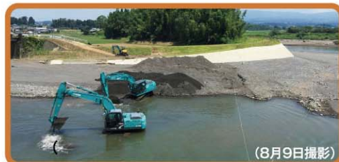
白川中流域堆積土砂掘削状況(大津町岩坂)
