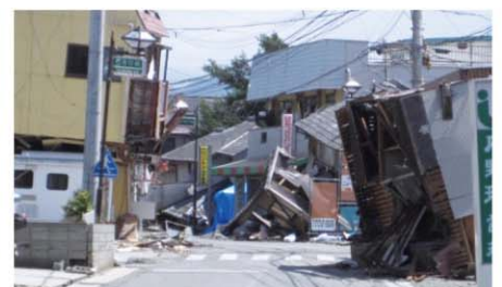
道路に倒壊した家屋(4月17日撮影)
