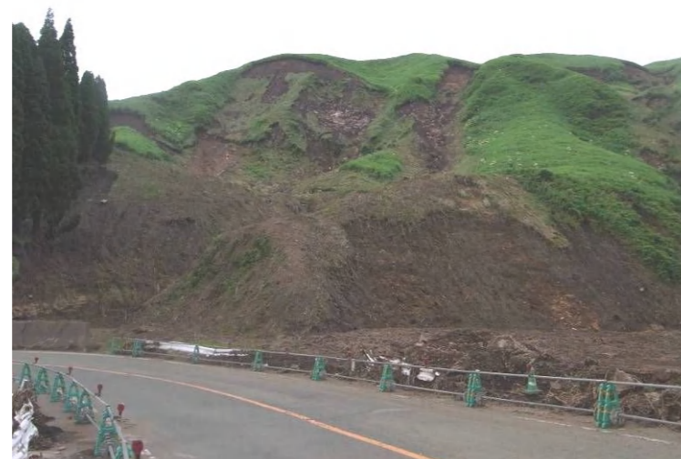
写真 2.2-1 妻子ヶ鼻付近の先阿蘇火山岩類 (破碎が進み、岩塊状となっている)
