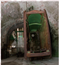
竖坑槽笼子 (电梯笼子) 竖坑槽ケージ
