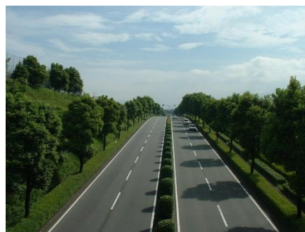
第二空港線の沿道景観（益城町）
