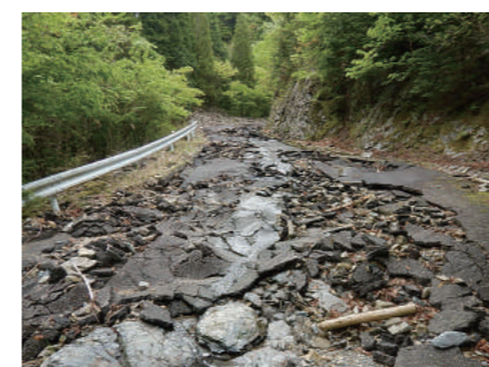
林道の復旧(五木村字下梶原地区)
