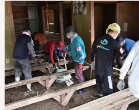
被災家屋の泥出しをするボランティア
