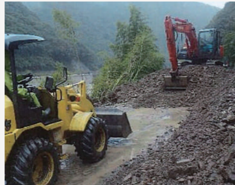
国道219号(球磨村神瀬地区)啓開作業
