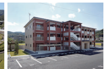
災害公営住宅の整備(提供:芦北町)
