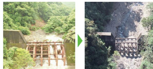
砂防堰堤の堆積土砂撤去(あさぎり町西平川)
