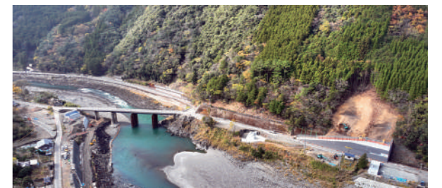
鎌瀬橋(八代市坂本町)の仮橋
