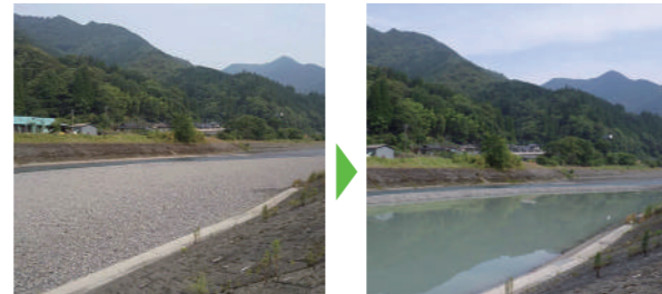
川辺川(五木村宮園)の掘削状況
