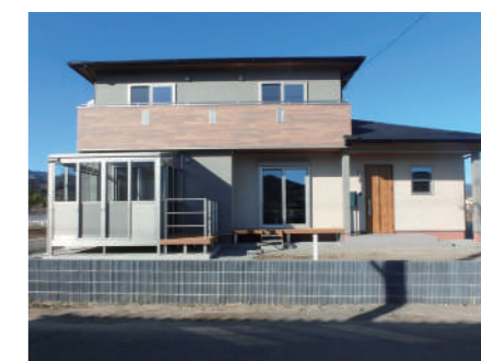
補助金を活用して施工した例
