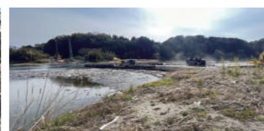
球磨川第四橋梁復旧工事
