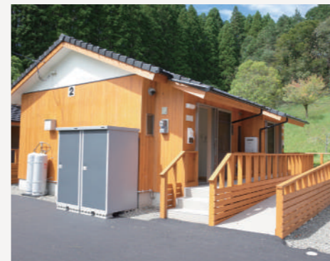
完成した応急仮設住宅(人吉市)
