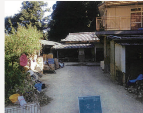
芦北町海浦地区 土砂撤去後(提供:芦北町)
