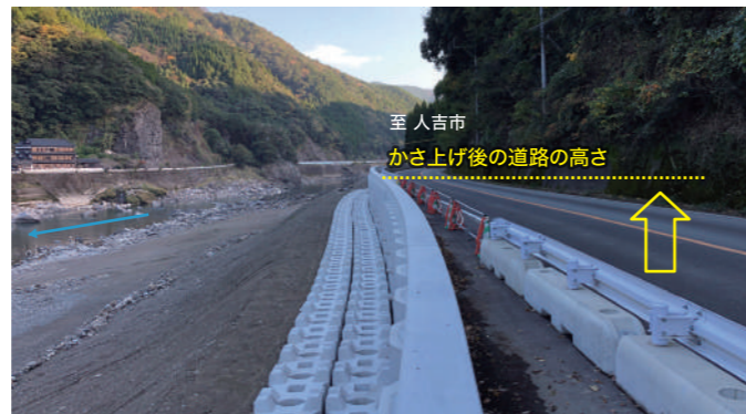
復旧状況(道路の復旧:かさ上げ)R5.11.7 至 人吉市 かさ上げ後の道路の高さ
