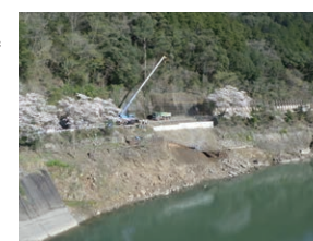
国道219号の復旧状況(八代市坂本町)
