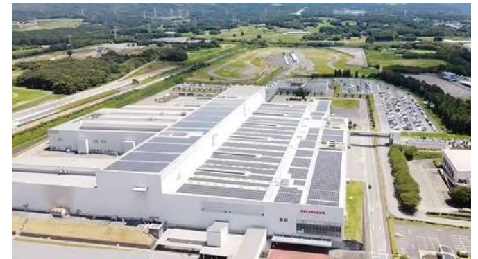
本田技研熊本製作所の屋根上太陽光発電施設
