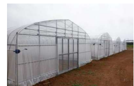
強化型パイプハウス整備状況
