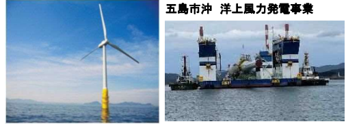
五島市沖 洋上風力発電事業
