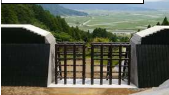
盤名木川第2砂防堰堤((阿蘇市)R4.6完成)
