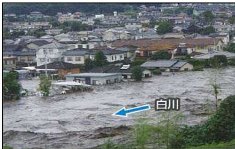
白川(県管理区間)：熊本市北区龍田1丁目 【ダム本体の工事状況】
