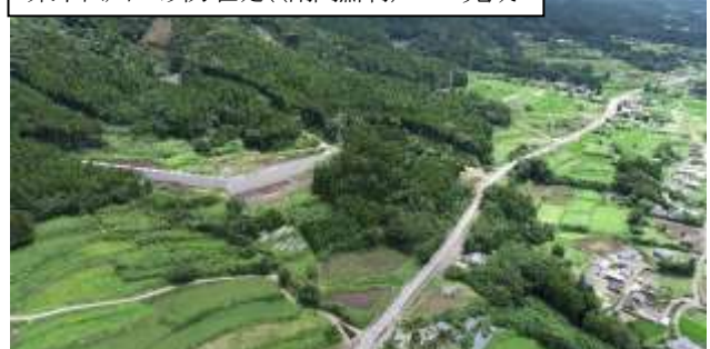
東下田川2砂防堰堤((南阿蘇村)R5.8完成)
