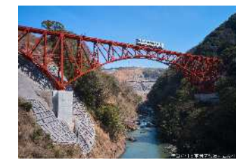
「南阿蘇鉄道」災害復旧工事完了
