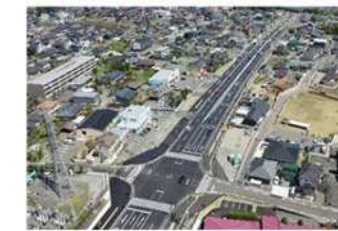
県道熊本高森線の4車線化
