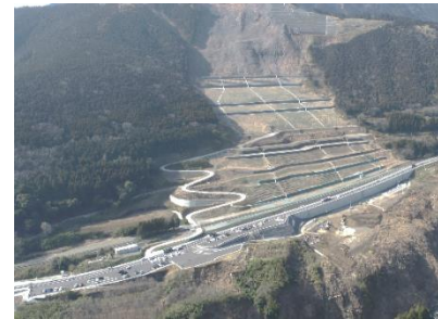
国道57号線現道部
