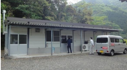
くねぶ加工施設整備予定地(旧味噌加工施設)
