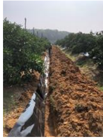
写真2 畝周りを掘削し防水防根シートを約50cm埋設
