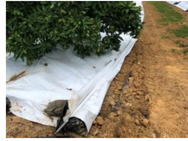
写真3 防水防根シート埋設後
